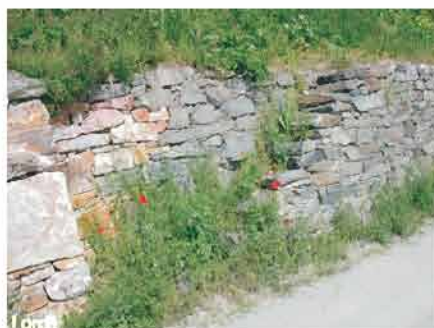
Weinbergsmauer aus Quarzit und Schiefer, den örtlich anstehenden Gesteinen
