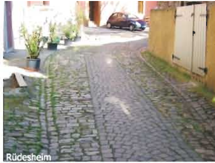
Kleinfugig verlegtes Pflaster erhöht den Gehkomfort. Die weniger intensiv genutzten Randbereiche sind grün
