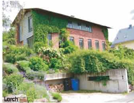
Punkt: Einzelhaus, freistehend
