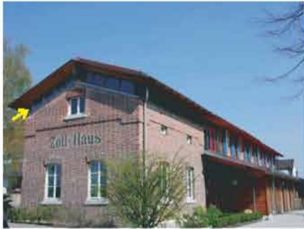
Gelungener Dachausbau: Eine „Glasfuge“ zwischen ursprünglicher Wandfläche und Dach ermöglicht die Beibehaltung von Dachform und -neigung und belässt die ursprüngliche Substanz ablesbar
