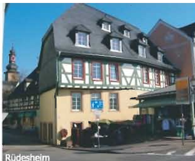
Große Dachfläche mit untergeordneten Sattelgauben
