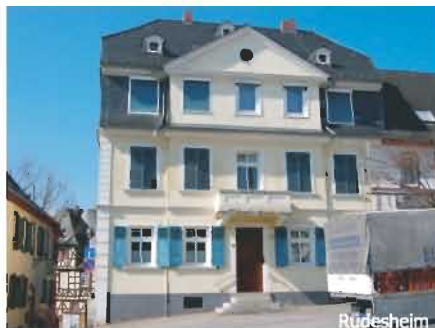
Die Mitte der Fassade wird durch ein Giebelzwerchhaus betont
