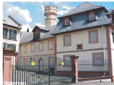
Hauptgebäude mit Mansarddach, Wirtschaftsgebäude mit Satteldach
