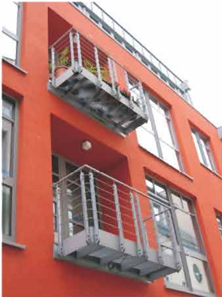
Moderner Balkon an modernem Gebäude: Durch die in die Fassadengliederung einbezogene Nische vergrößert sich die nutzbare Fläche des Balkons, ohne dass die Auskragung ein gestalterisches Übergewicht bekommt
