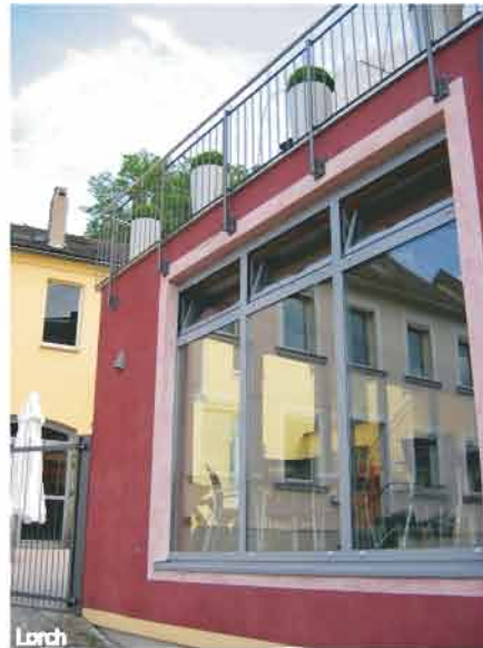
Anbau mit Nutzung als Dachterrasse: Das schlichte, aber hochwertige Geländer wurde in seiner Gliederung auf die Fensterartellung abgestimmt. Die transparente Konstruktion dominiert nicht das Gebäude
