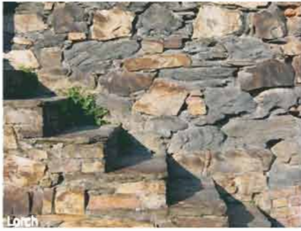
Bruchstein dient als landschaftsangepasster Baustoff für Sockelgeschosse und Stützmauern - mit den varilierenden Farbschattierungen wird das Bauwerk Teil der Kulturlandschaft
