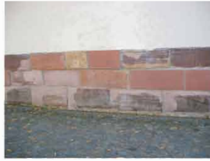
Vorbildlich: Für die Ausbesserung dieser Sandsteinmauer wurde das gleiche Material verwendet, allerdings ohne eine Unregelmäßigkeit zu imitieren, die nicht der heutigen Zeit entspricht
