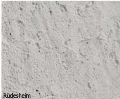
Verputztes Mauerwerk mit einer natürlichen Unregelmäßigkeit
