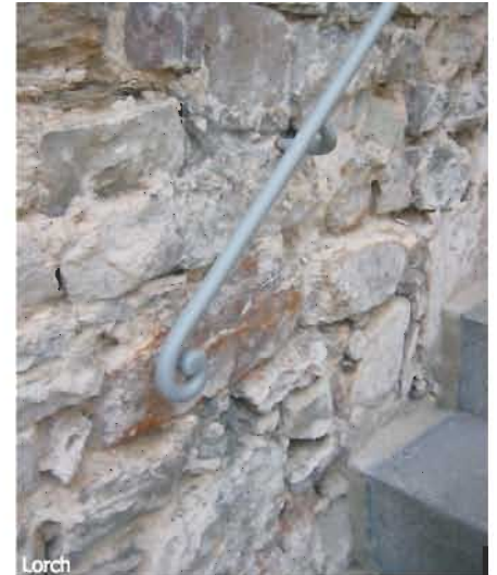
Das schlichte Geländer harmonisiert perfekt mit der Lebendigkeit des Mauerwerks
